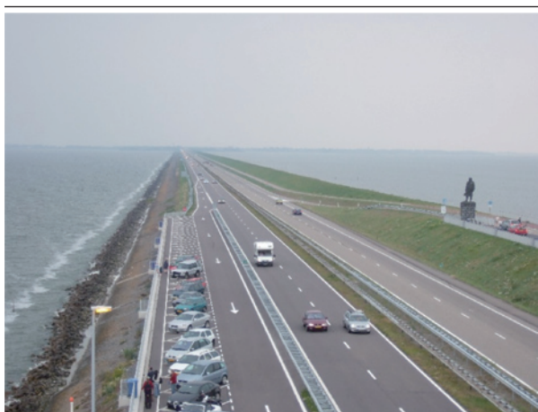
写真2 30キロメートルの大堤防
